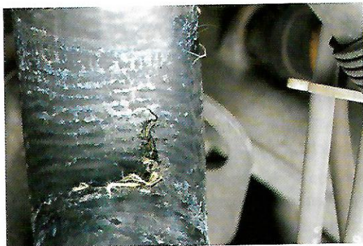
Ryc. 13.15. Uszkodzony przewód układu chłodzenia
